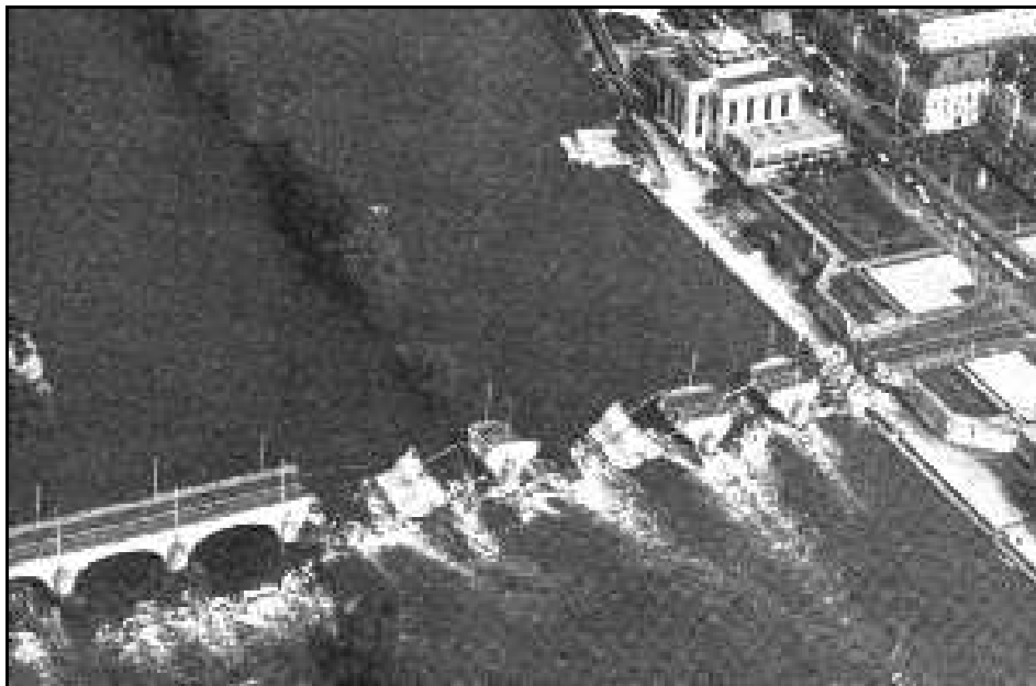
Photographie 1 – L'effondrement du Pont Wilson à Tours en 1978. (source privée).
