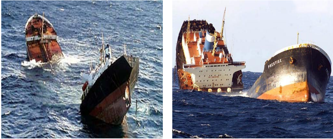
FIG. 1.2 – Rupture de la structure du pétrolier “Prestige” consécutivement à une tempête en novembre 2002 ( http://www.hydrolance.net )
