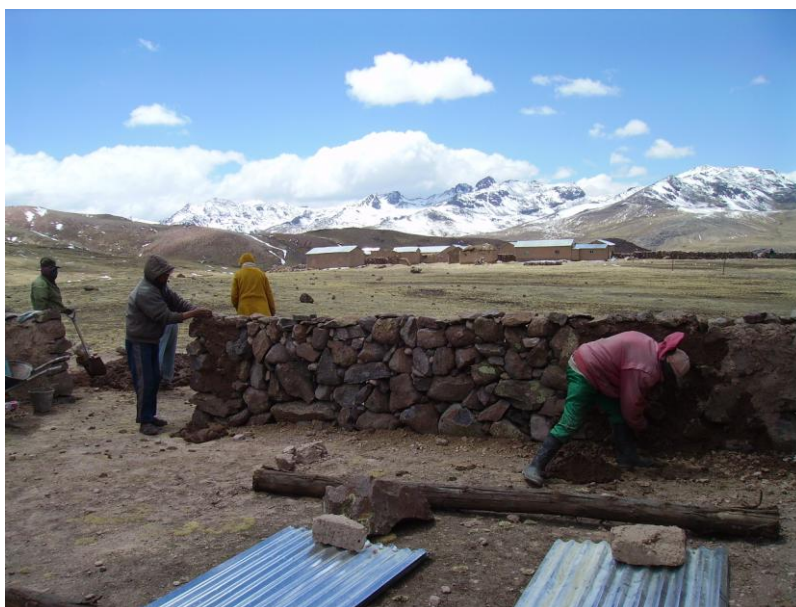
Photo 45 – Faenas dans la communauté de Llanca pour la construction de l'étable (septembre 2005)
