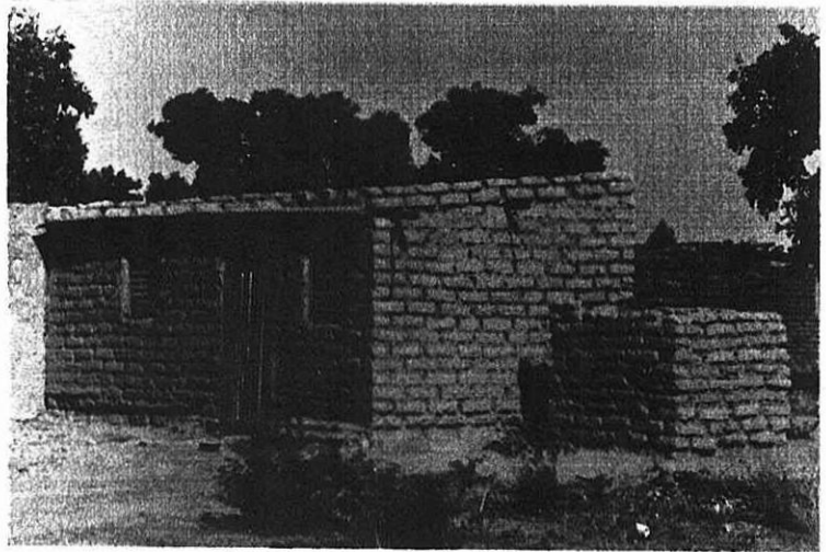
Habitat en banco d'une parcelle non lotie au secteur 28 : bâtiment principal et "douche".
