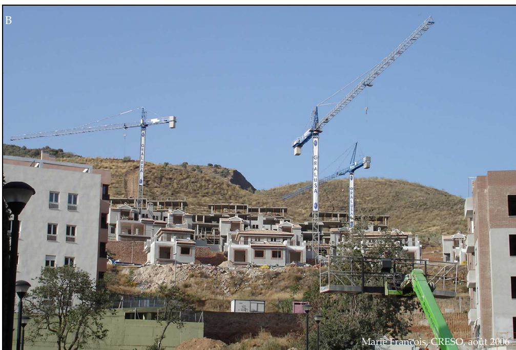
La nouvelle urbanisation du groupe immobilier Gralusa, sur la route de la Sierra à la sortie de Grenade, est composée de maisons de trois étages.
