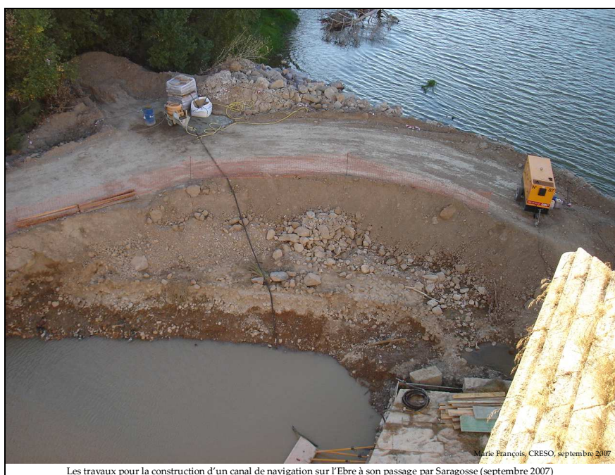
Photographie n°24. Travaux du canal de navigation (septembre 2007)
