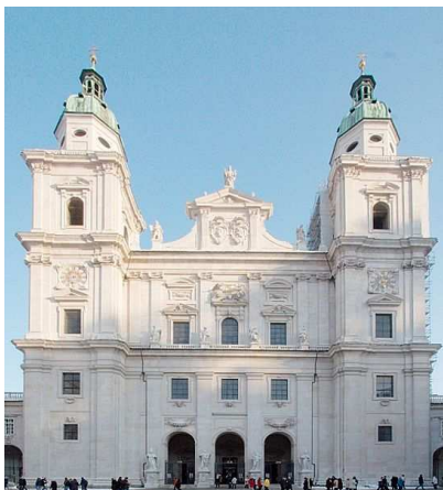
Figure 3.34 : Façade de la Cathédrale de Salzbourg en marbre d'Untersberg
