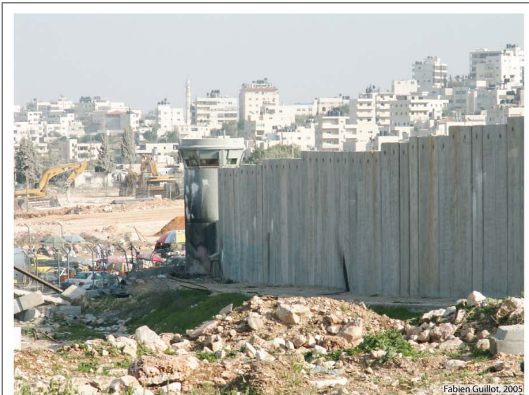
Figure 47. Mur ou barrière ? un cloisonnement bien réel
