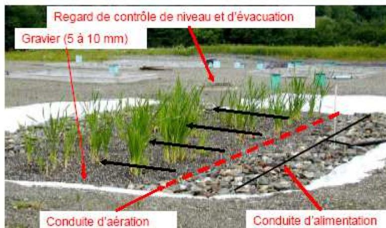
Figure 14 : Photographie et représentation schématique de l'installation d'un marais artificiel
