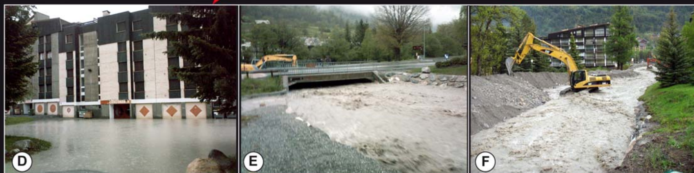
D, E et F : 26/05/2008 - Crue du torrent du Bez. D: Inondation des jardins privatifs de l'ensemble Concorde (vue vers l'aval) (source: J. Demoulin). E: Torrent du Bez sous le pont de la RD 1091 (Ex RN 91). Forte aggradation tirant d'air réduit et débordements en rive gauche (vue vers l'aval) - source: J. Demoulin). F: Interventions d'urgence: curage du lit torrentiel du Bez et endiguements provisoires sous forme de merlons (vue vers l'aval). Source: SGMB (R. Lestoumelle)
