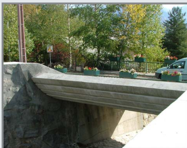
10/10/2007: "casquette" en béton armé sur le pont des Neyzets. Source: L. Thénard.
