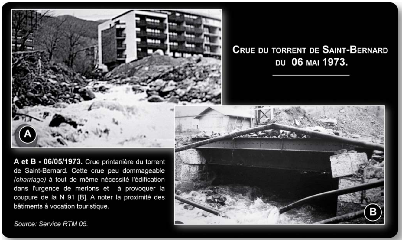
Figure 149 : Crue du torrent de Saint-Bernard du 06 mai 1973.
