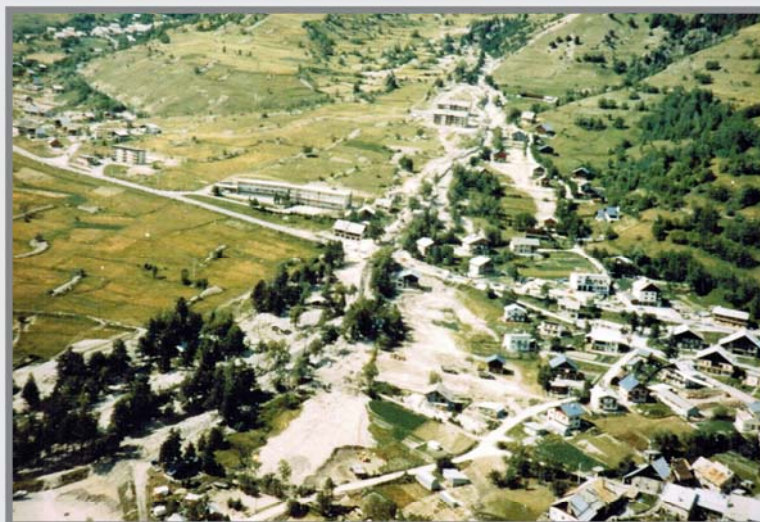
09/07/1981: Vue aérienne oblique sur le cône de déjection du torrent du Verdaire. Les secteurs blanchâtres à proximité du chenal correspondent aux débordements de la lave torrentielle. Source: RTM 05.
