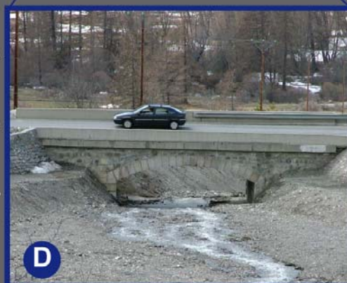
Figure 109: Une tendance actuelle à la protection "passive" sur les cônes torrentiels : l'exemple du Saint-Joseph.
