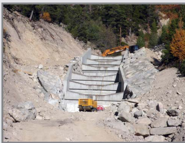
19/10/2008: Mise en place de deux caissons stabilisateurs dans la section supérieure du Grand Verdarel. Source: SGMB.
