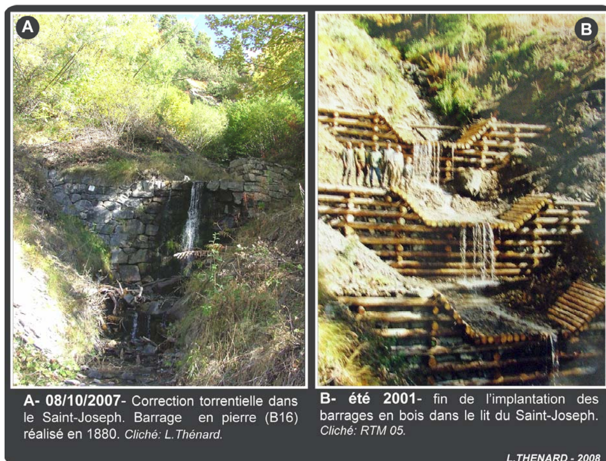
Figure 106: Correction RTM passée et actuelle dans le torrent de Saint-Joseph (Comm. du Monétier-les-Bains).
