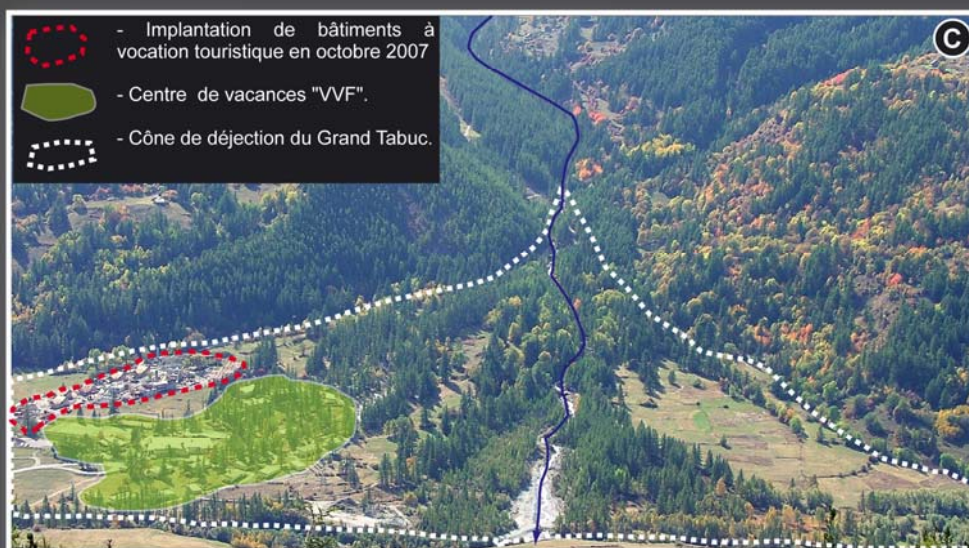
C -09/10/2007 - Aménagements sur le cône du torrent du Grand Tabuc.
