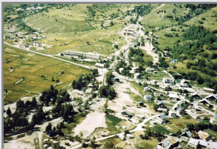
09/07/1981: Vue aérienne oblique sur le cône de déjection du torrent du Verdarel. Les secteurs blanchâtres à proximité du chenal correspondent aux débordements de la lave torrentielle. Source: RTM 05.
