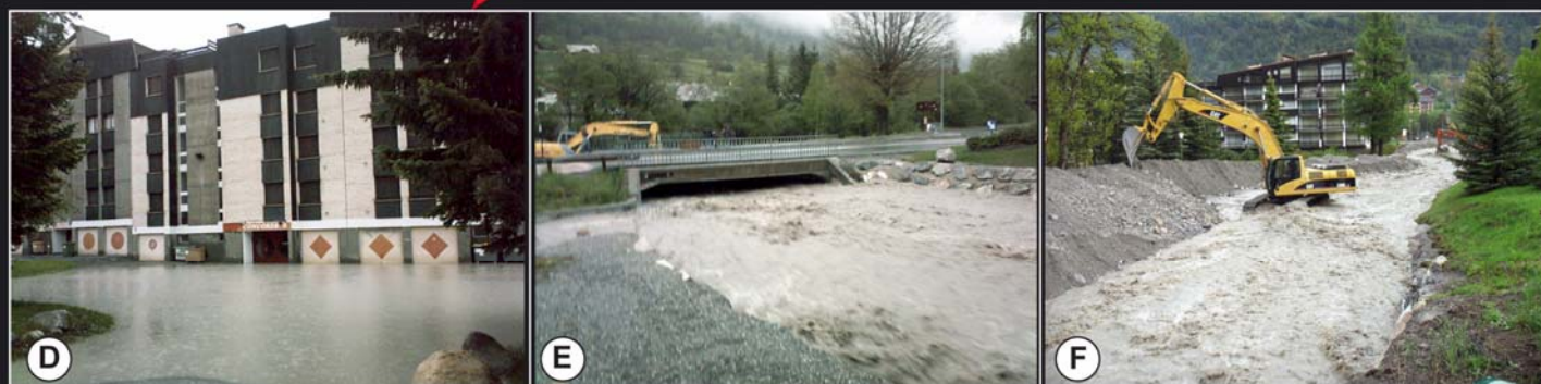
D, E et F : 26/05/2008 - Crue du torrent du Bez. D: Inondation des jardins privatifs de l'ensemble Concorde (vue vers l'aval) (source: J. Demoulin). E: Torrent du Bez sous le pont de la RD 1091 (Ex RN 91). Forte aggradation tirant d'air réduit et débordements en rive gauche (vue vers l'aval) - source: J. Demoulin). F: Interventions d'urgence: curage du lit torrentiel du Bez et endiguements provisoires sous forme de merlons (vue vers l'aval). Source: SGMB (R. Lestoumelle)
