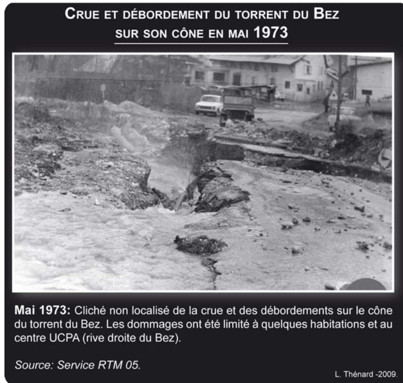
Figure 153 : Crue et débordement du torrent du Bez en mai 1973.
