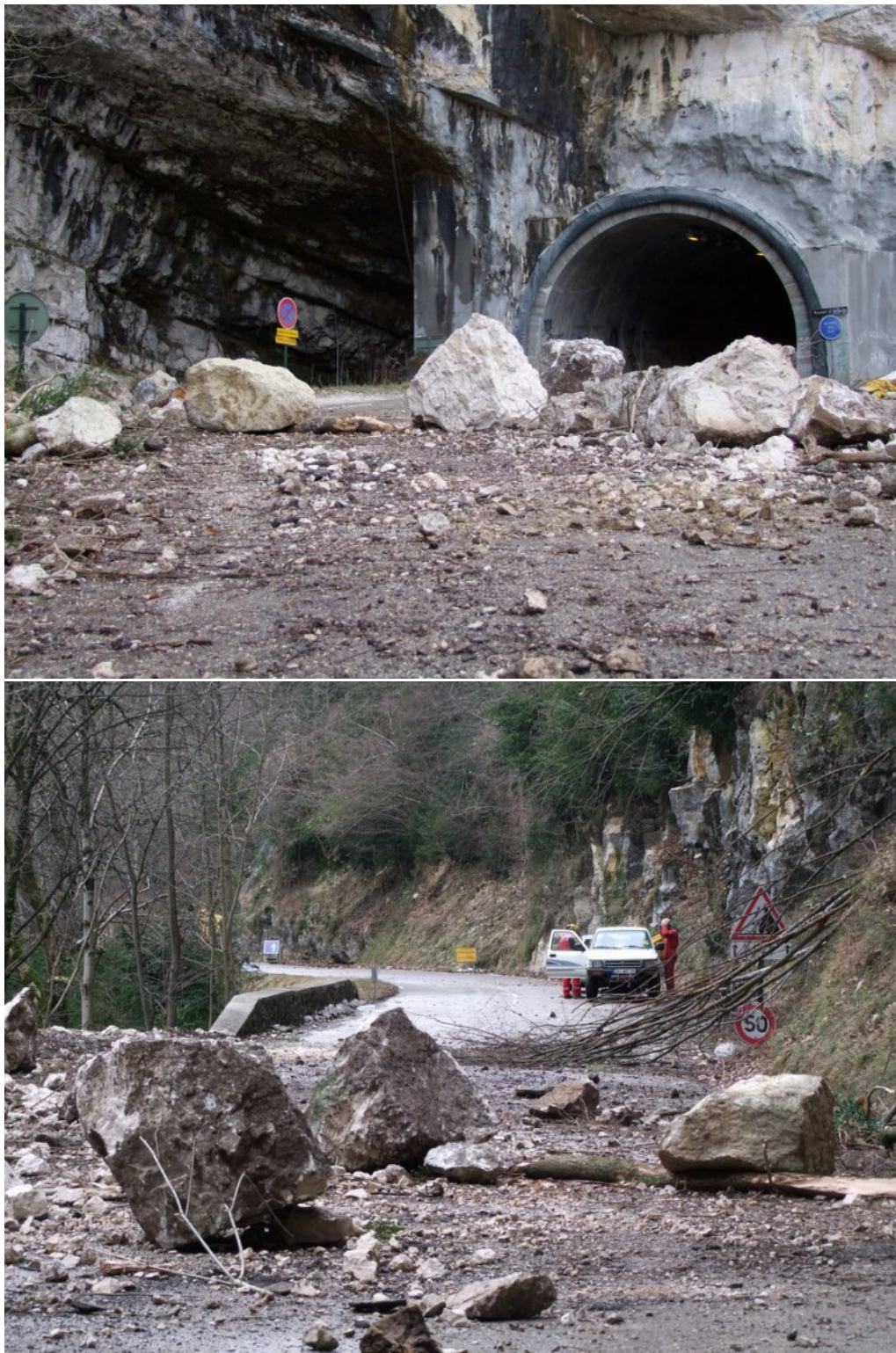
FIG. 2 – Photos de l'éboulement du 19 Janvier 2009 dans les Gorges de la Bourne (site internet de la société Géolithe : http://www.geolithe.com )
