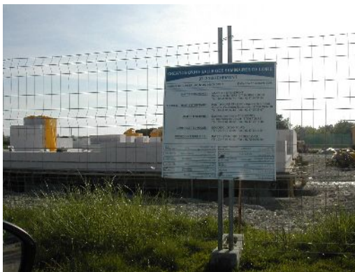
Chantier de la salle de séminaire de Loire
