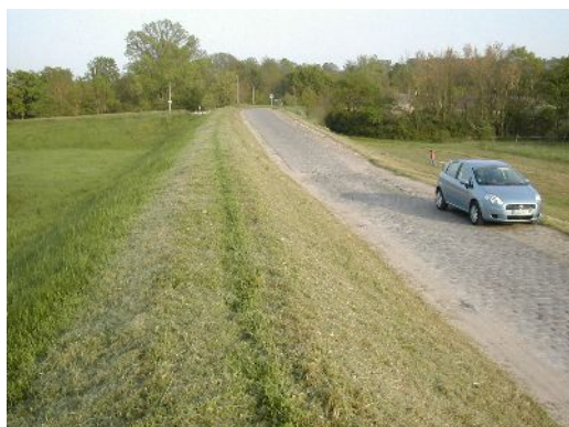
Déversoir de la Chapelle-aux-Naux
