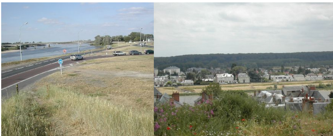
Déversoir de la Bouillie après le sens interdit
