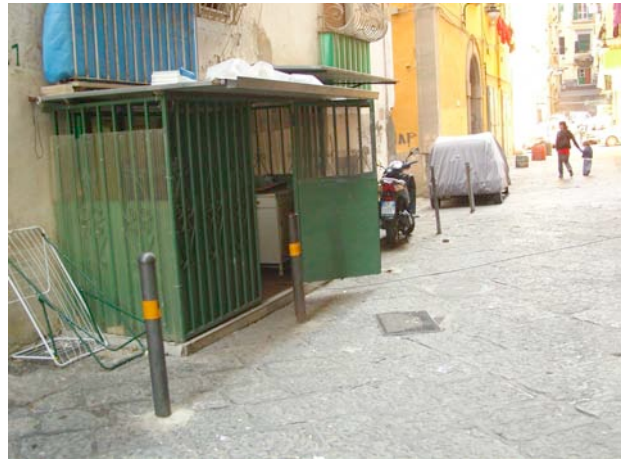
Fig. 2.30. Véranda métallique et plots de démarcation
