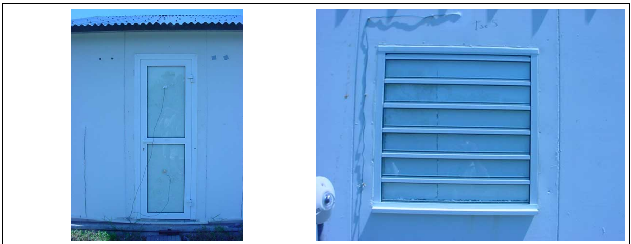
Figure 12 : Configuration de la cellule LGI pour la phase de validation expérimentale ; les vitrages de la porte et de la jalousie sont occultés afin que le rayonnement solaire ne pénètre pas dans la cellule
