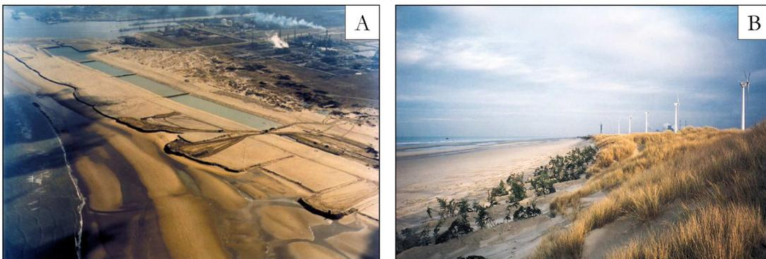
Figure.I.3 : A : Creusement du canal des Dunes. B : Mise en place de fascines pour faciliter l'accumulation éolienne. Prise de vue P.A.D. (1982).
