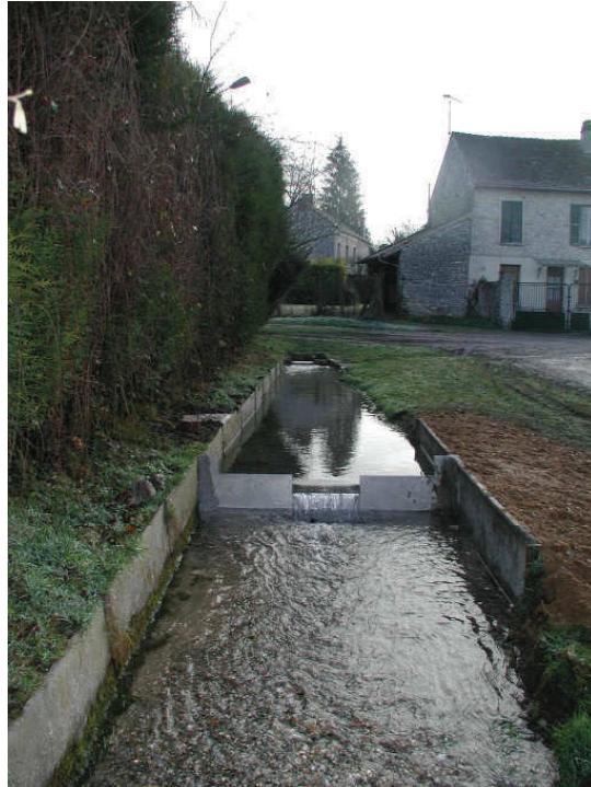
Figure 2.7 – Nouveau déversoir installé le 12 janvier 2005
