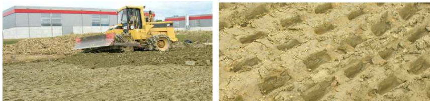
FIG. 52 : Compactage in situ de la barrière argileuse d'après Camp 2008.
