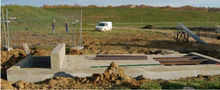
FIG. 90 : Fosse en béton armé avec emplacement de la plaque (à droite) d'après Camp (2008).
