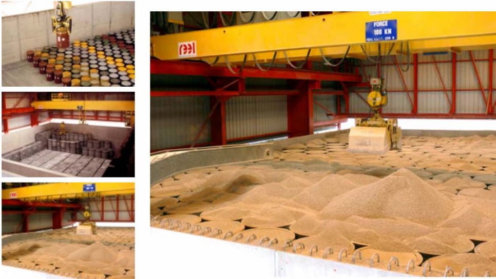
Figure 1-6 : Mise en place des couches des déchets dans le centre l'Aube
