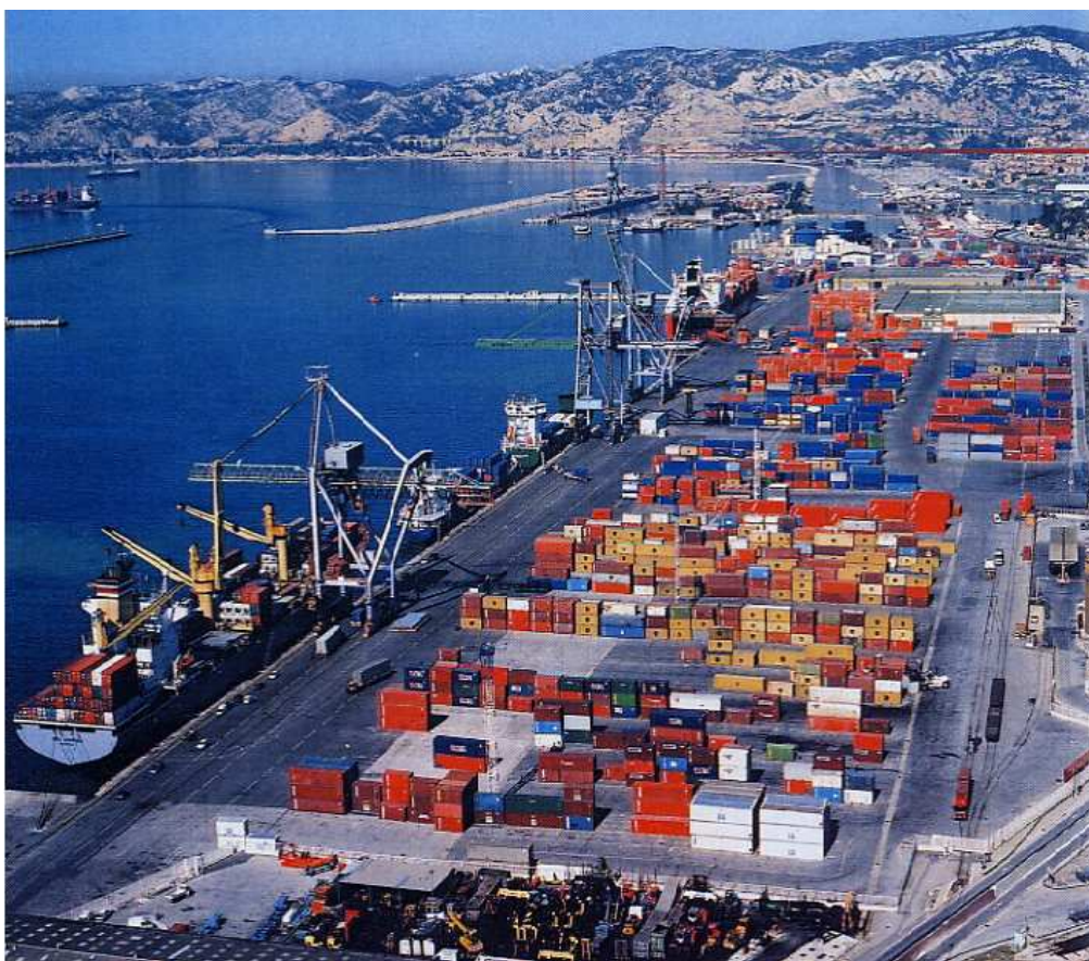
Terminal de conteneurs de Marseille, France
