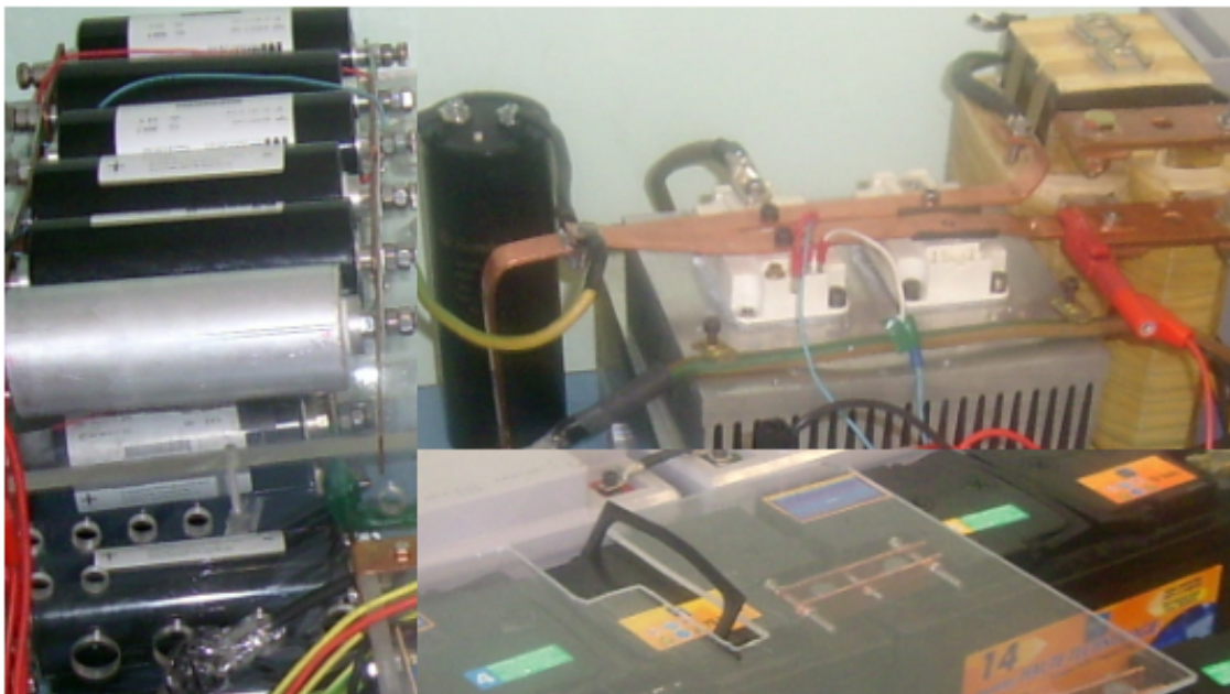
Fig. 3.5: Photographie du convertisseur dévolteur-survolteur
