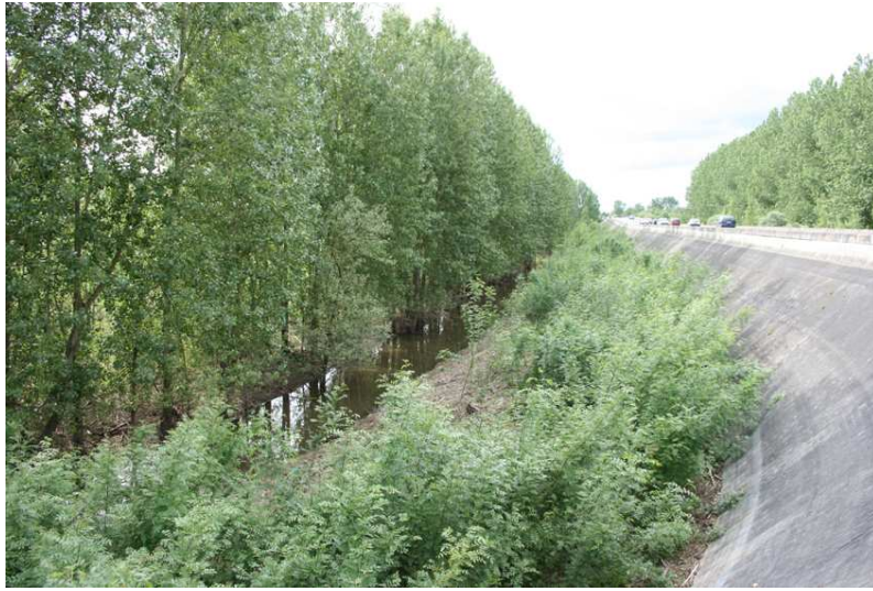
Figure 20. Vue de la levée de Briollay. Mai 2008. Cliché Lemoine Estelle.
