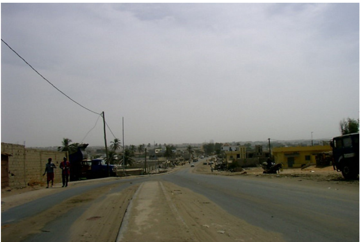
Photo 32. Route de Malika relevée avec les ordures lors de sa construction en 1967. En arrière plan on aperçoit le paysage des Niayes ; l'entrée de la décharge se situe environ 1 km plus loin à gauche. (Cliché DIAWARA A-B 2007).
