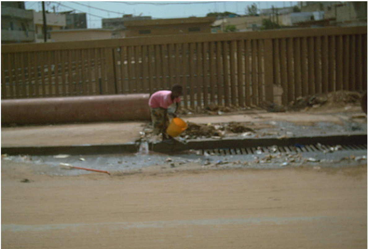
Photo 66. Ménagère jetant des eaux domestiques dans les regards de collecte des eaux pluviales sur une route de Grand-Yoff...réécemment réfectionnée. Dans certains quartiers, les populations utilisent le réseau d'évacuation des eaux pluviales pour l'élimination « sauvage » des eaux résiduaires ménagères. Souvent la fraction grasse accompagnée de débris organiques provoque le colmatage des grilles avaloirs, situation qui nécessitera alors l'intervention du service des eaux. (Cliché DIAWARA A-B 2007)
