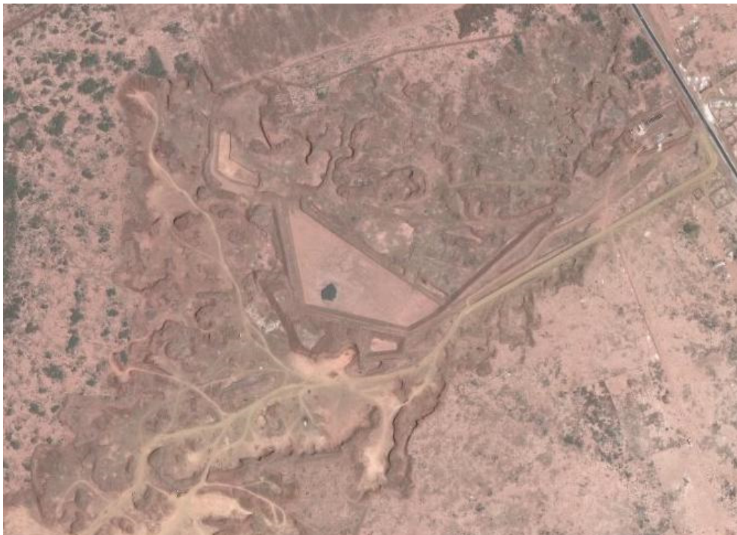
Photos 127 & 128. Images aériennes 17 & 18. Casiers en cours de réalisation, avec bassin de captage des lixiviats. (Crédit photo Google Earth 2009).
