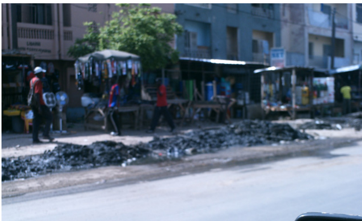
Photo 63. Boues de curage d'égouts, abandonnées in situ vers Grand-Yoff. Même si des agents de l'office National de l'Assainissement sont parfois impliqués, cette pratique est généralement l'œuvre des entreprises, à qui l'organisme officiel, sous-traite le service d'entretien des équipements dans certains quartiers. (Cliché DIAWARA A-B 2007)
