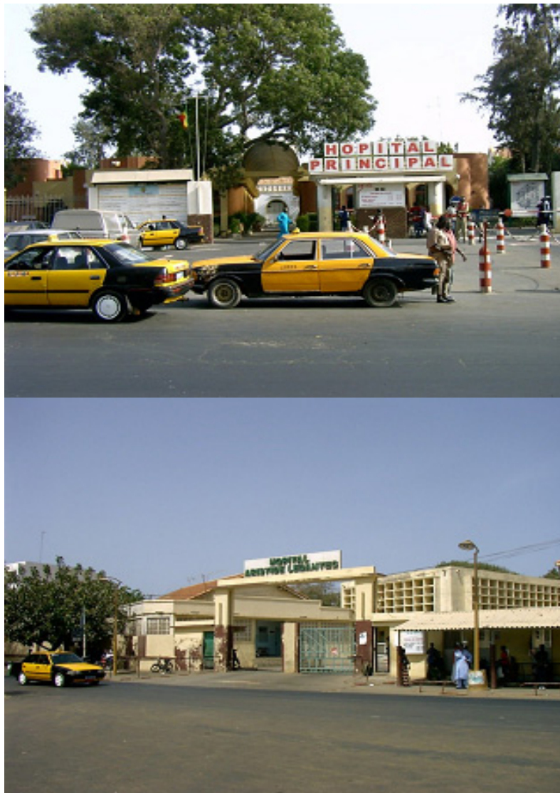
Photos 11 & 12. Entrées des hôpitaux « Principal » et « Le Dantec » au Plateau. (Cliché Diawara A-B 2008)
