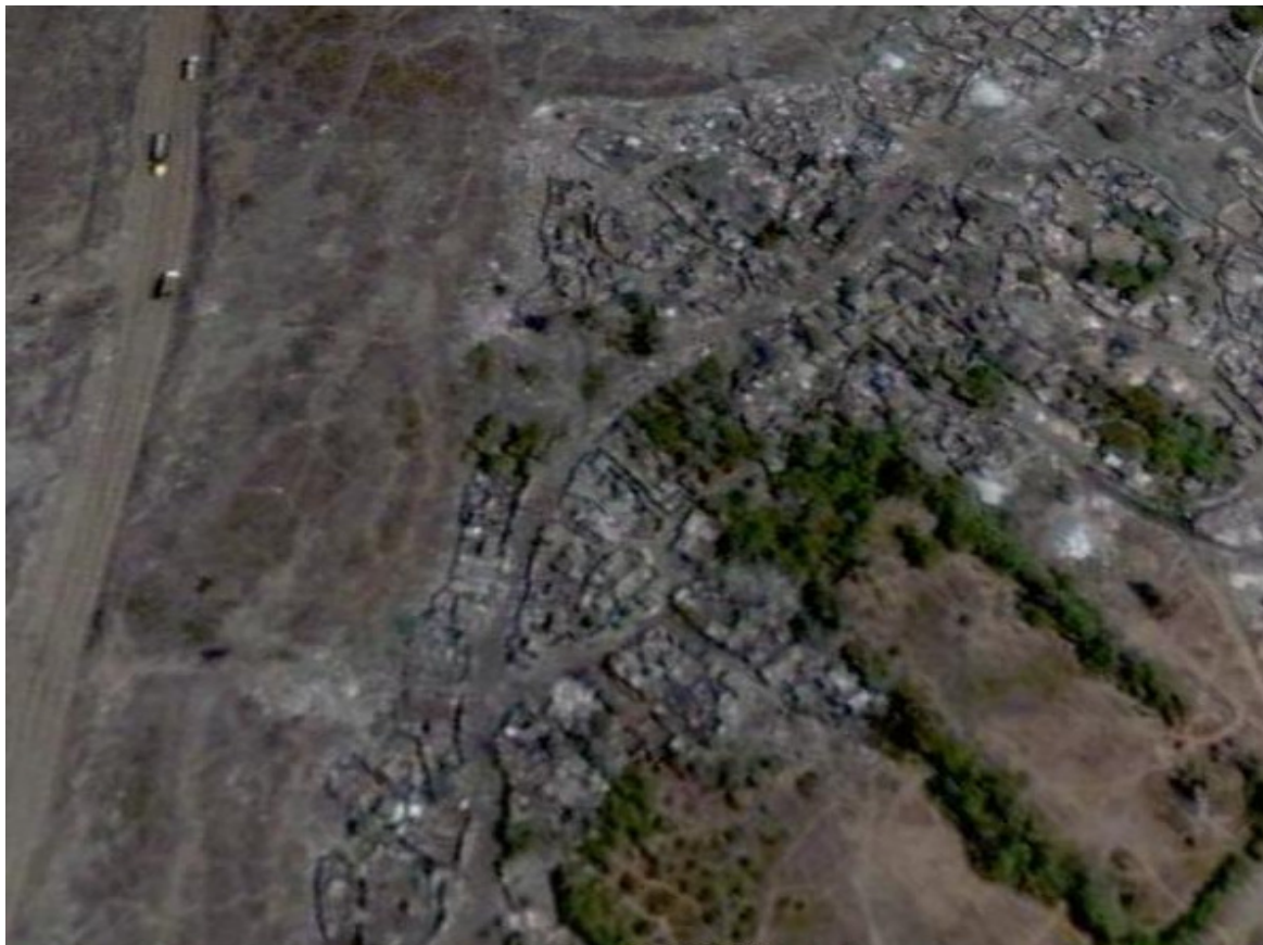
Photo 120. Image aérienne 12. Villages de récupérateurs installés sur le site de la décharge. (Crédit photo Google Earth 2009).
