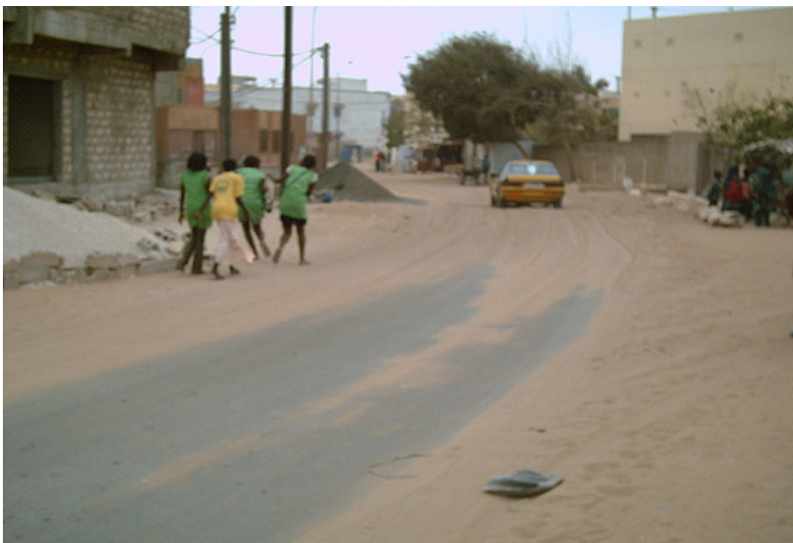
Photo 58. Axes routiers et trottoirs non stabilisés dans la zone sablonneuse des Parcelles Assainies. L'infrastructure ainsi que les ouvrages de drainage des eaux pluviales sont en permanence envahies par le sable. (Cliché DIAWARA A-B 2006)
