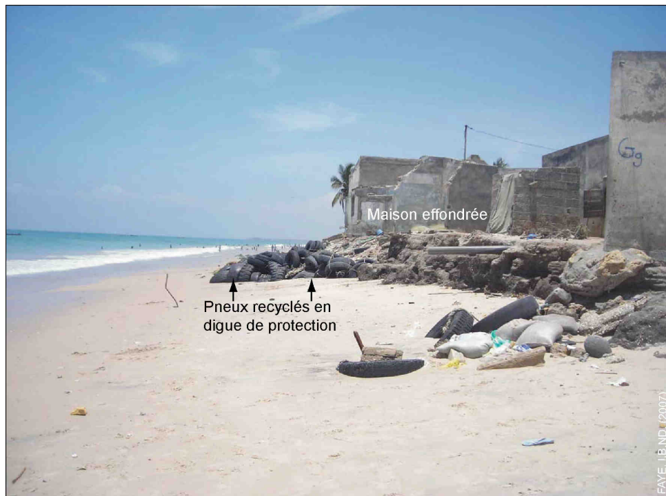
Photo 56 : Conséquences de l'érosion côtière à Bargny Guedj : effondrement de concessions et stratégies de protection avec des pneus usagés et des sacs de sables. Photo prise au sud du village en direction du nord, le 28-08-2007.
