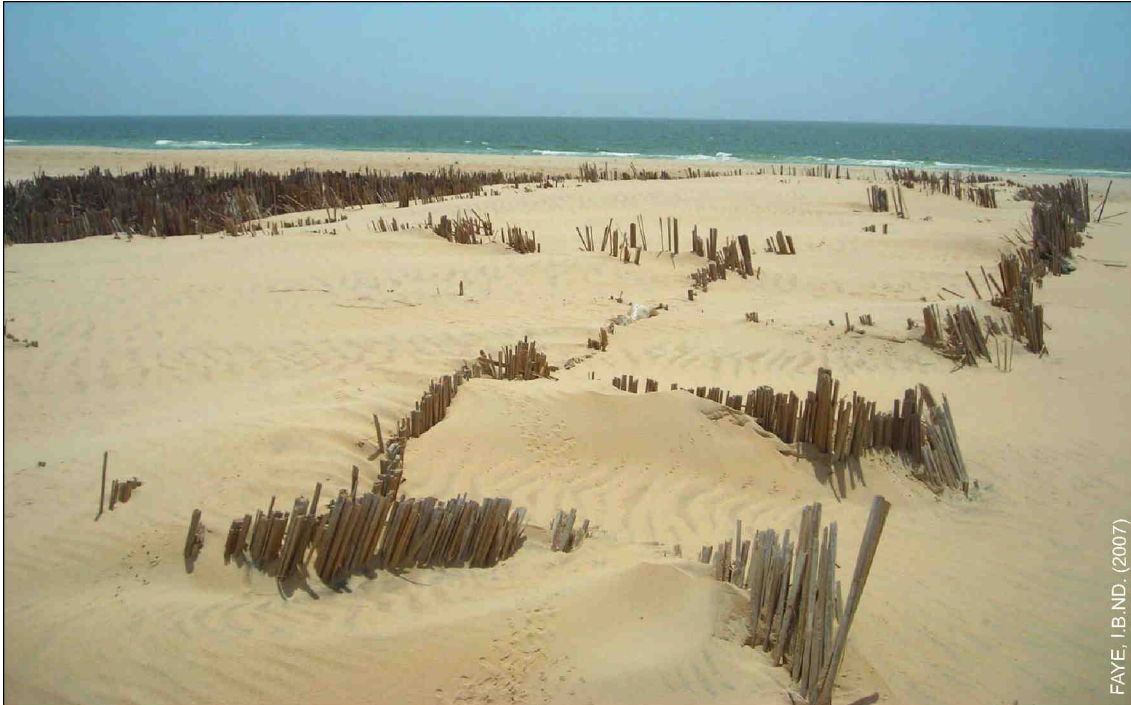
Photo 40 : Fixation du cordon dunaire par clayonnage avec des palissades en tige de Typha entre le port de pêche et l'hôtel Ahmedy. Vue prise en direction de l'ouest, le 22-08-2007.
