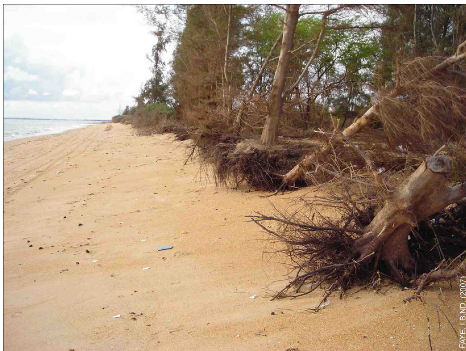
Photo 58 : Filaos déracinés au sud de l'épi du club Aldiana. Photo prise en direction du nord, le 03-08-2007.
