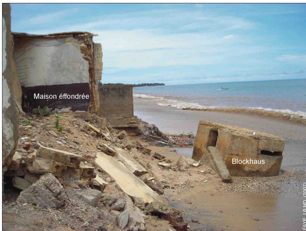
Photo 59 : Effondrement de maisons à Nianing sous l'effet de l'érosion côtière. Photo prise en direction du sud, le 03-08-2007.
