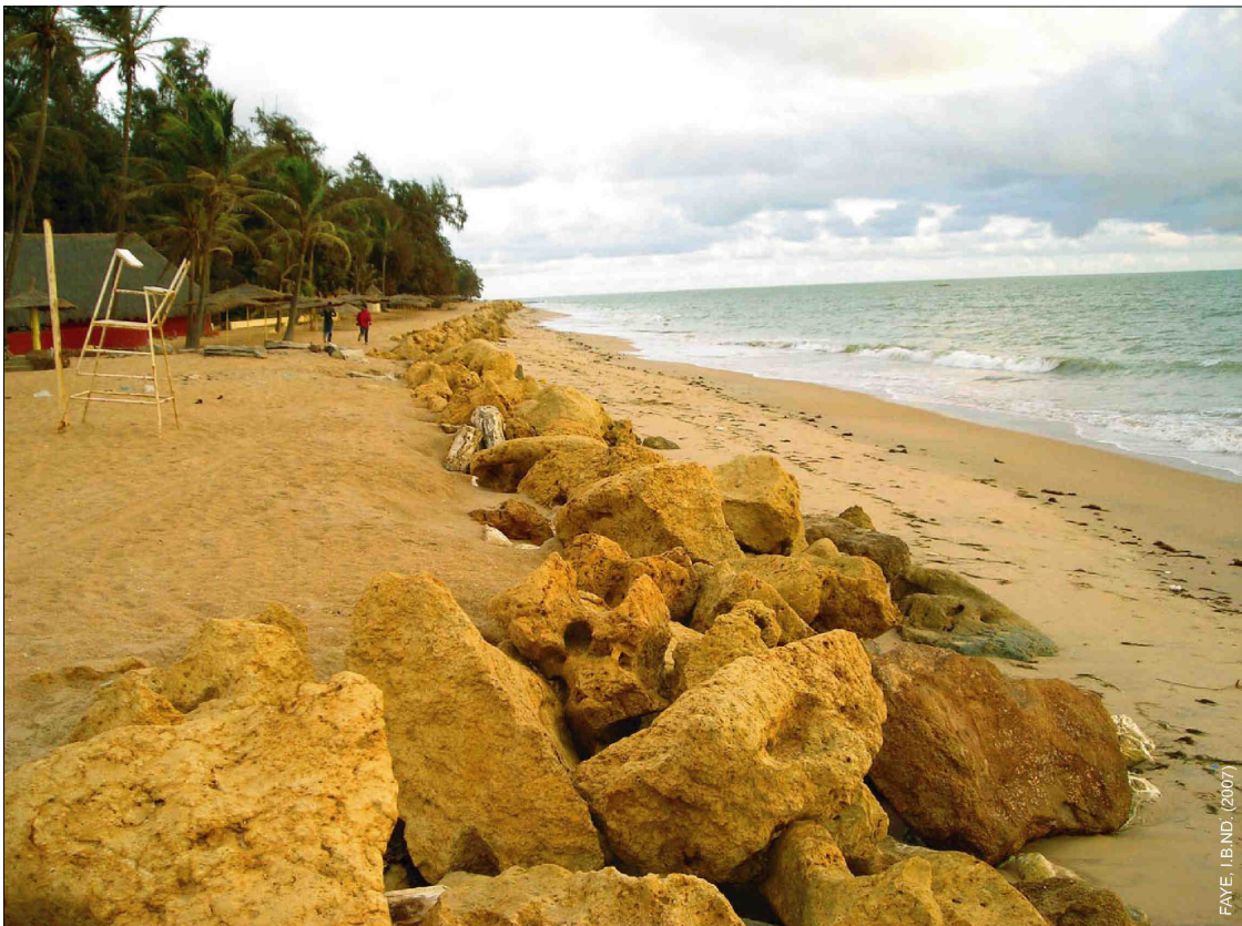
Photo 53 : Vue du cordon d'enrochement au droit du club Aldiana. Photo prise en direction du sud, le 02-08-2007.
