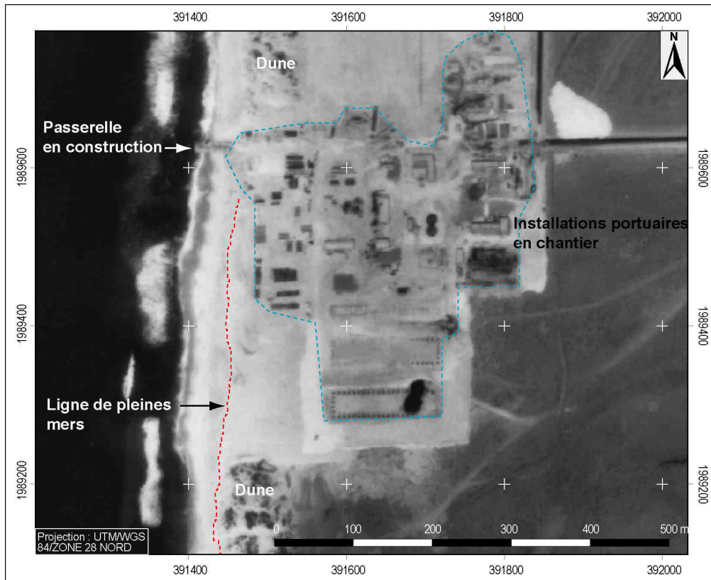
Photo 32 : Démantèlement de la dune devant les infrastructures portuaires en chantier. La ligne de pleines mers est également peu nette en raison d'un contraste très médiocre au niveau de la plage sur les images aériennes de Nouakchott (Extrait d'une photographie aérienne, mission IGN MAU-4-215, 1980, cliché n°5).
