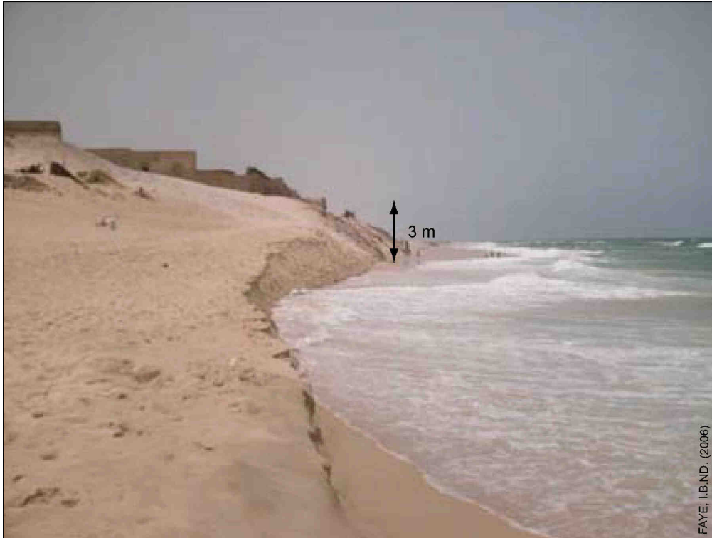
Photo 55 : Erosion du pied de dune au nord du village de Ndiago. Photo prise en direction du sud, le 13-07-2006
