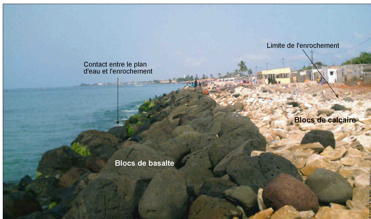
Photo 18 : Vue du cordon d'enrochement protégeant le littoral rufisquois. Photo prise au quartier de Thiawllène, en direction du nord, le 22-10-2006.
