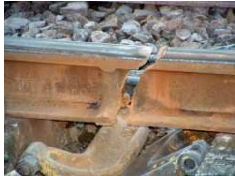
(b) Rupture simple sur soudure
