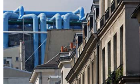
Gros plan sur les tubes d'aération bleus de Beaubourg, quartier des Halles, Paris
