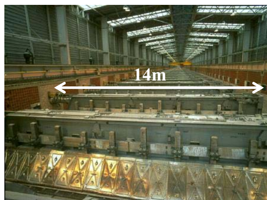
Figure I-2. Photo d'une série de cuves AP30 vues de côté (Rio Tinto Alcan)
