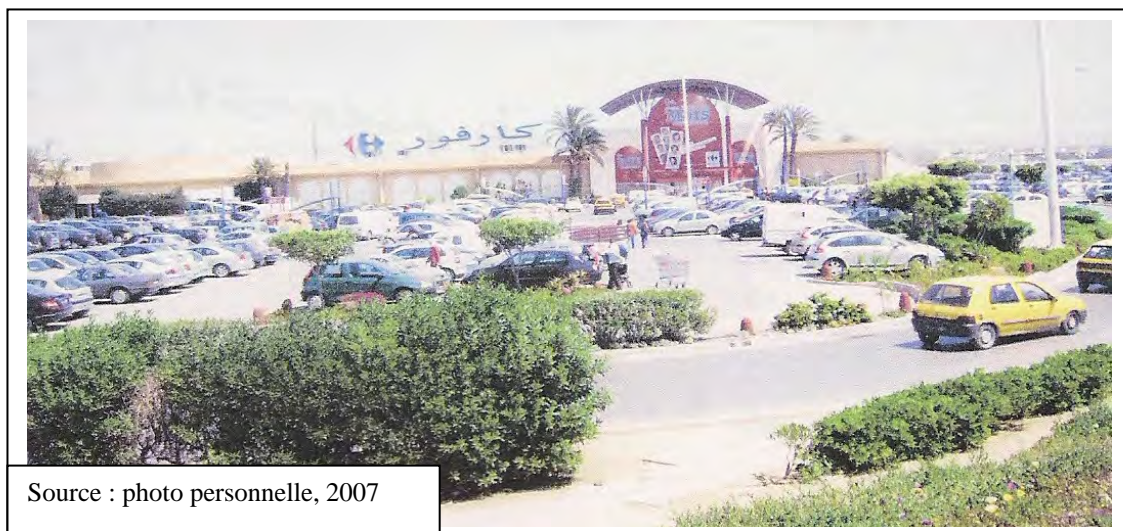
Figure n° 44: Le centre commercial carrefour à Tunis
