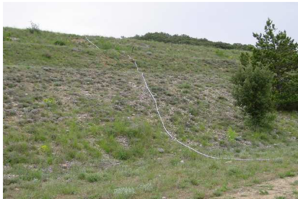
(b) Tuyau permettant le transport de l'eau du canal
