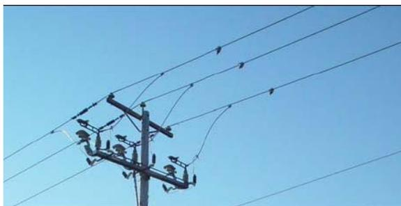
Figure 1.5 : interrupteur HTA sans pouvoir de coupure installé sur un pylône
