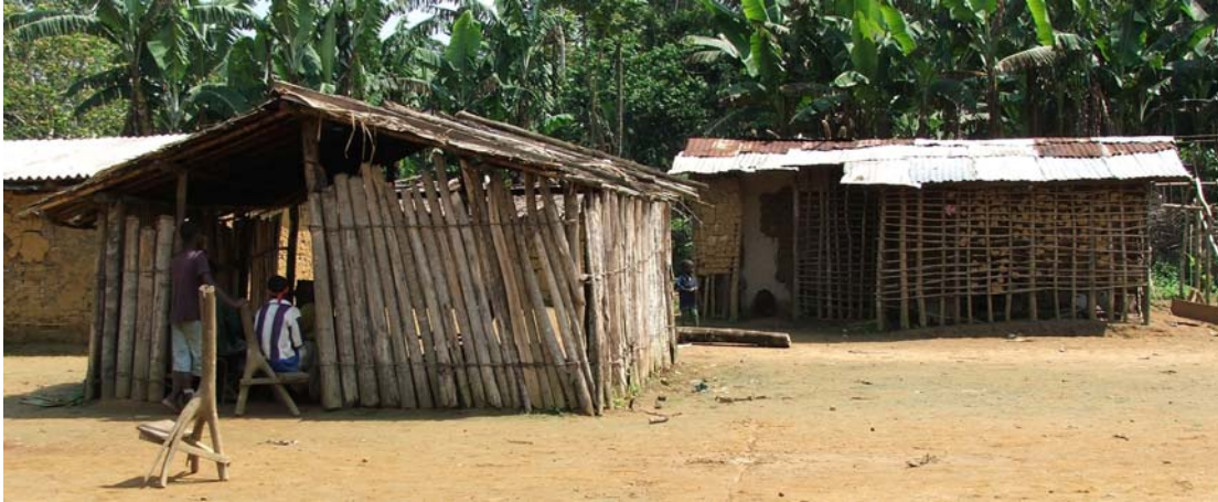
Photo 70. Corps de garde au premier plan et maison, Imbong.
