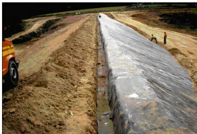
fig. 2.9. Tranchée d'ancrage (d'après [Bri01]).
