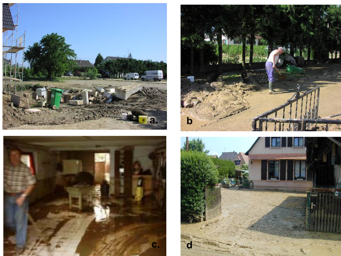
Figure 2.10 : Exemples de dégâts dans les zones urbanisées. a et b. A Blotzheim (Haut-Rhin – Clichées : Armand, 2003); c. En Belgique (Cliché : Evrard) ; d. A Landser (Haut-Rhin – Cliché : Auzet, 2003)
