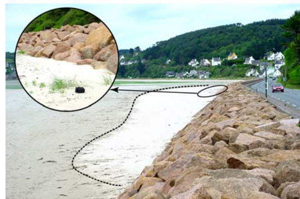
Photo 19. Construction d'une banquette pré-dunaire (sables vifs clairs soulignés par la ligne en pointillé) et installation d'une végétation halonitrophile (cliché S. Suanez, 13/06/2002)
