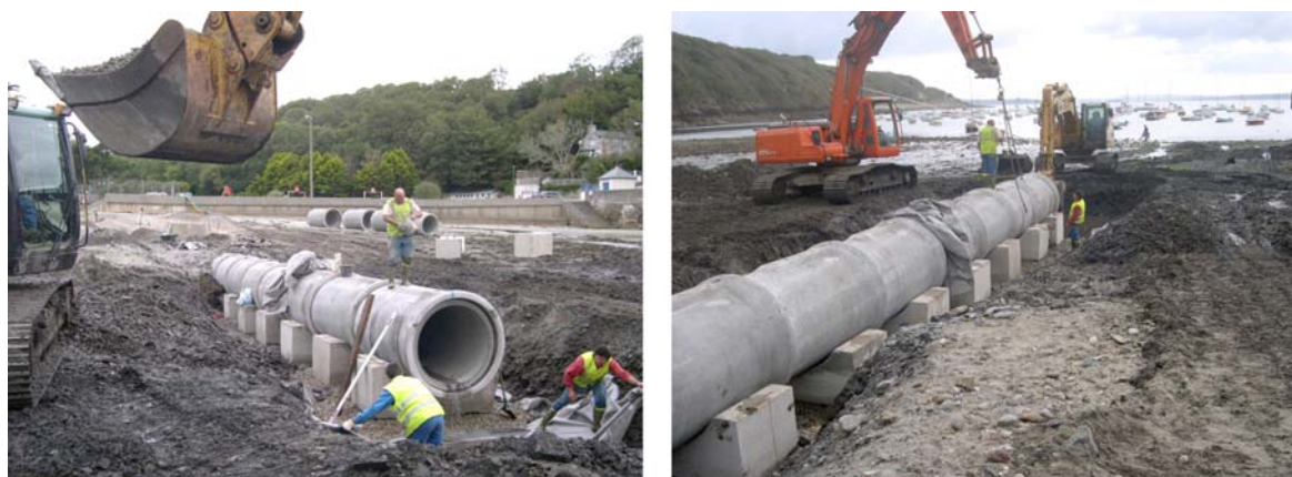
Photo 28. Tavaux de rallongement de la buse d'évacuation des eaux fluviales sur la plage de Sainte-Anne-du-Portzic (clichés S. Suanez, septembre 2007)
