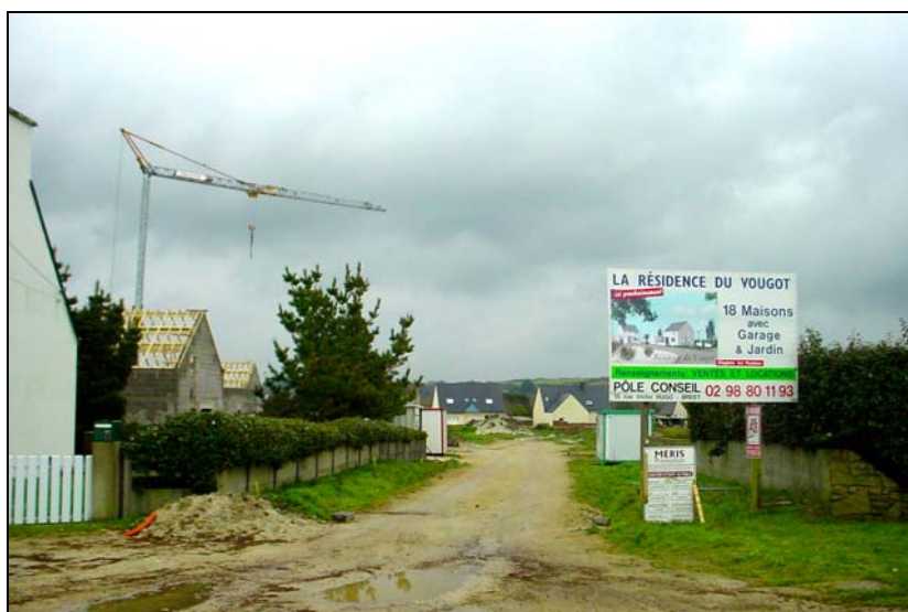
Photo 22. « La résidence du Vougot » constituée d'un lot de 18 maisons en cours de construction à l'arrière du cordon dunaire dans la zone potentiellement inondable (photo S. Suanez, 22/03/2007)
