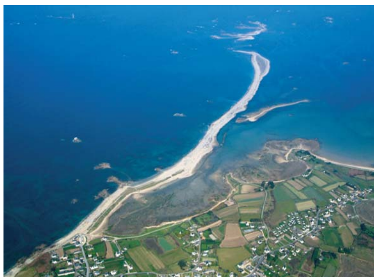
Photo 14. Vue aérienne du Sillon de Talbert (mars 2007)
