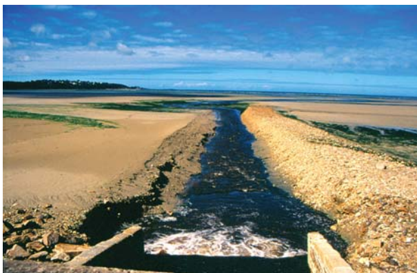
Photo 18. « Armement » de la rive droite du Yar par la construction d'un bourrelet artificiel constitué de matériaux grossiers issus du curetage du fond du lit (cliché S. Suanez 15/09/2000)
