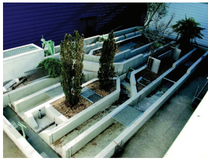
(a) Vue du canal
