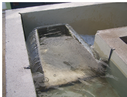
(c) Déversoir en bec de canard
