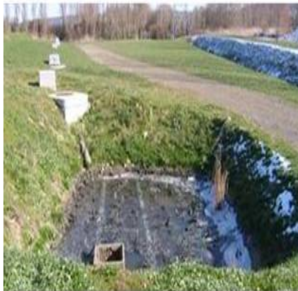
FIGURE 1 Casier à tourbe de la station d'épuration de Honfleur (France, 2005).
