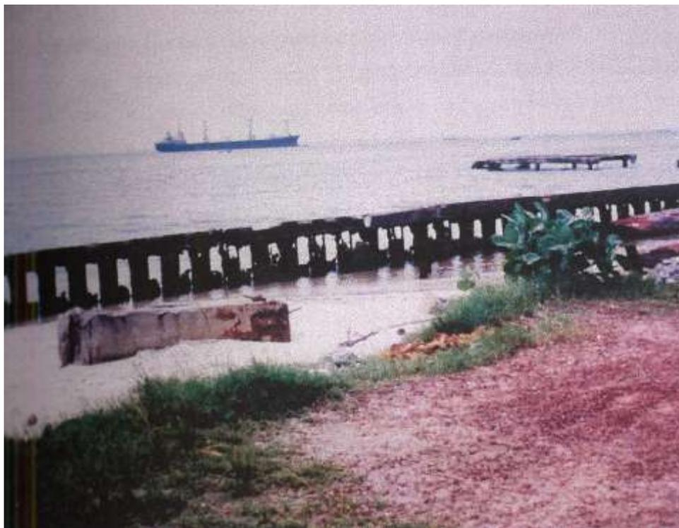
Photo 17 : Dégradation des palplanches le long du bord de mer de Port-Gentil (Mombe, 2000)
