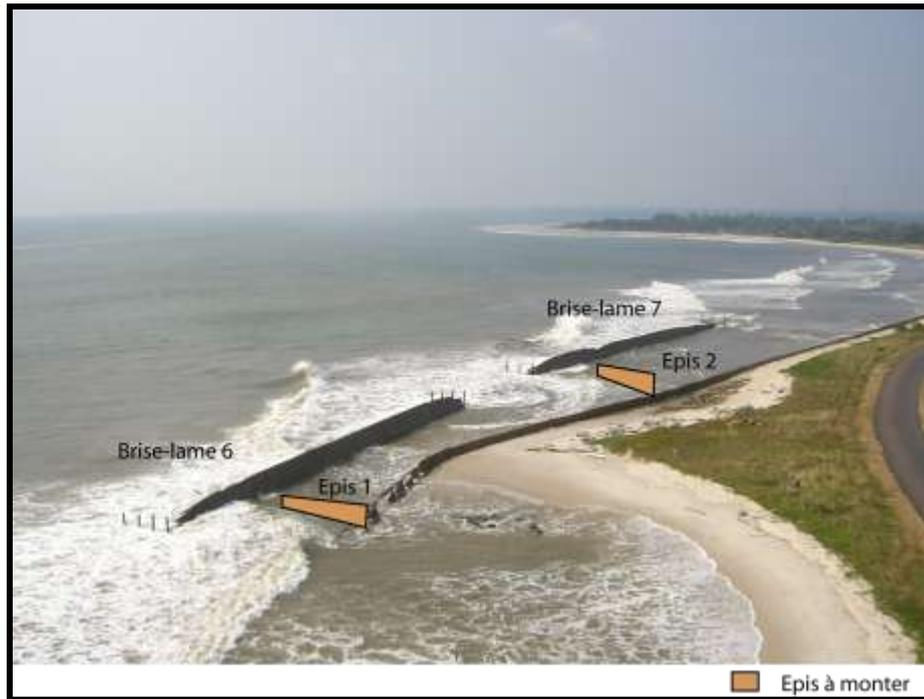
Figure 110 : Actions envisageable pour la formation des tombolos à l'arrière des brise-lames
