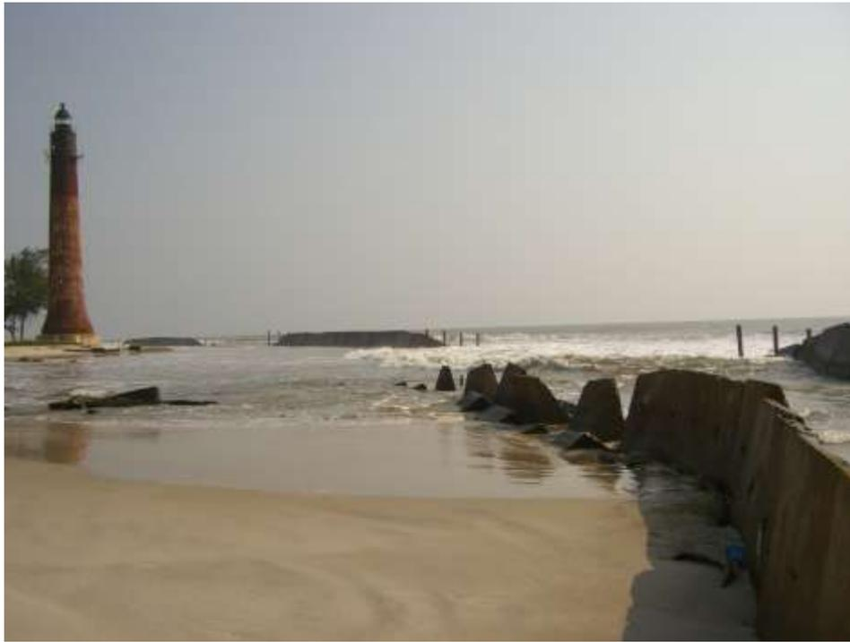
**Photo 16 : Destruction du mur de protection « Saout » (Menie, 2007)**
