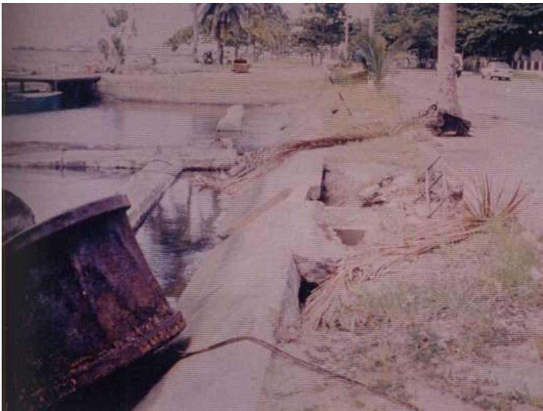
**Photo 19 : Perré en béton détruit par les vagues sur le front de mer de Port-Gentil (Mombé, 2000)**
