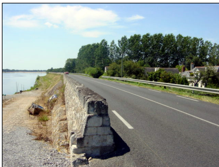
Photographie 85 : La levée à La Bohalle : côté Loire le renforcement de l'ouvrage est réalisé, côté val les travaux sont suspendus en attendant la décision du tribunal administratif (réal. H. Davodeau, juillet 2003).
