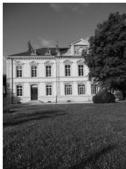
Figure 41. Bâtiment de MINATEC IDEAs Laboratory (droit d'image réservé)
