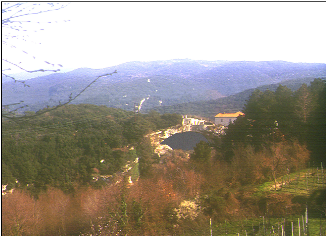
Fig. 61 : Vue du site d'Arma delle Manie et de ses environs, depuis le Sud
