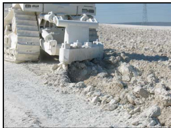
Figure 2.8 : Traitement de craie sur le chantier de la LGV Est [HENRY]
