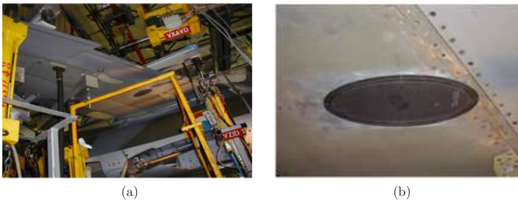
FIGURE 1.1 – Photographie d'une réparation par collage de patch composite sur une aile d'avion. Vue globale (a) et détaillée (b) de la réparation. Photographies CEAT.
