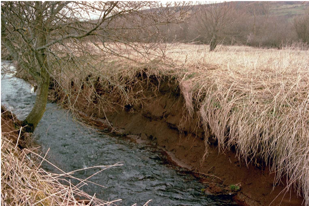
Photographie 7 : Fossé de drainage dans la partie centrale des Narces de Ribains
