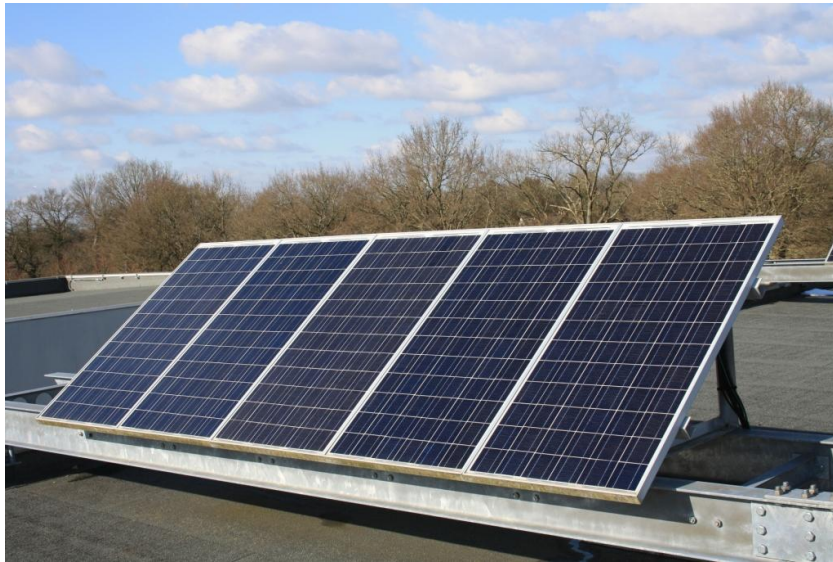
(a) 2 kW c de panneaux PV Silicium polycristallin
