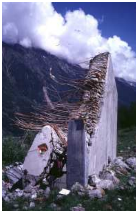
FIGURE 1.5 – Dent paravalanche du dispositif de Tacconnaz après l'avalanche de 1999, Cemagref/Taillandier J.M.
