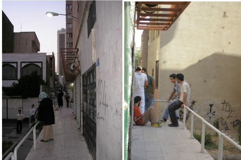
Coursives d'accès aux habitations de Navab - 2007
