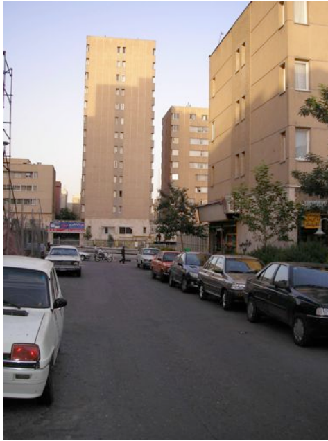
Rue débouchant sur Navab - 2007
