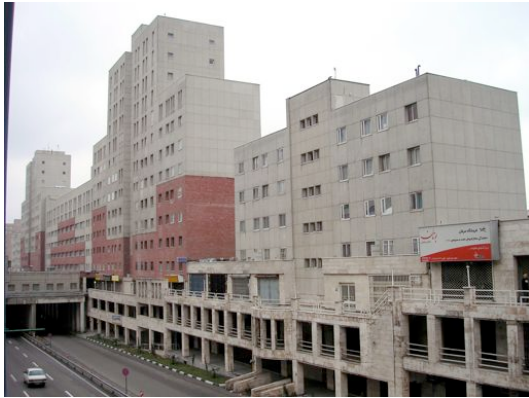
Commerces accessibles depuis les coursives - 2007
