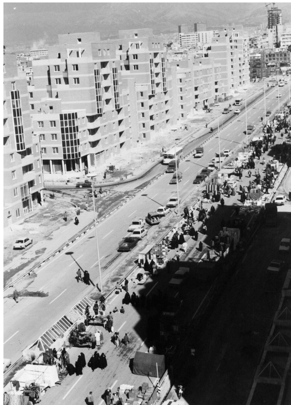
Construction de la Phase I projet Navab Project - Source: TAC
