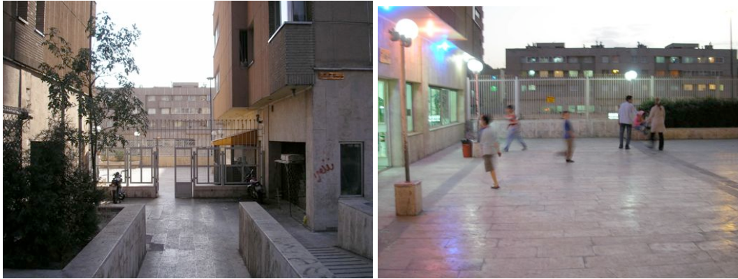
Placette sur dalle en cœur d'îlot desservant les immeubles d'habitation - 2007
