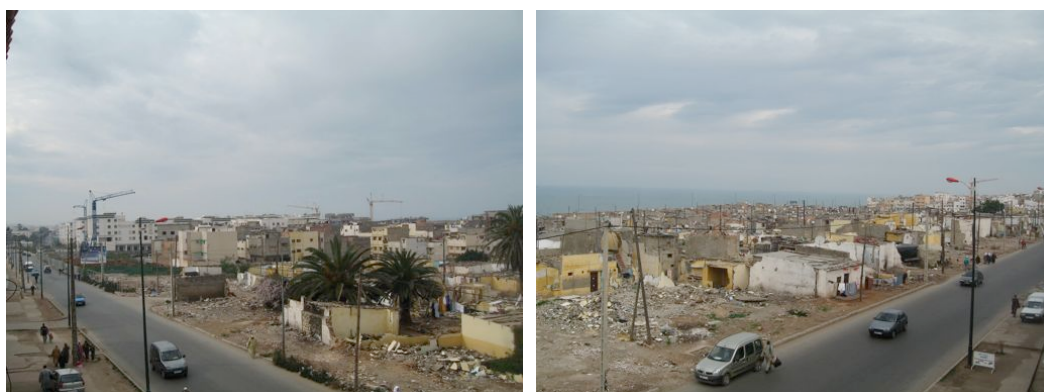
Douar Al kora en cours de démolition - 2007
