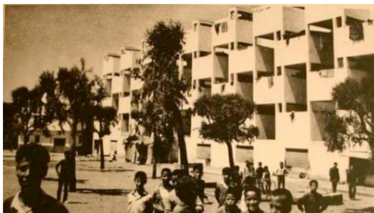
Immeuble « Nid d'abeille » à Casablanca, 1952 (Candilis, Woods architectes). Source : IFA
