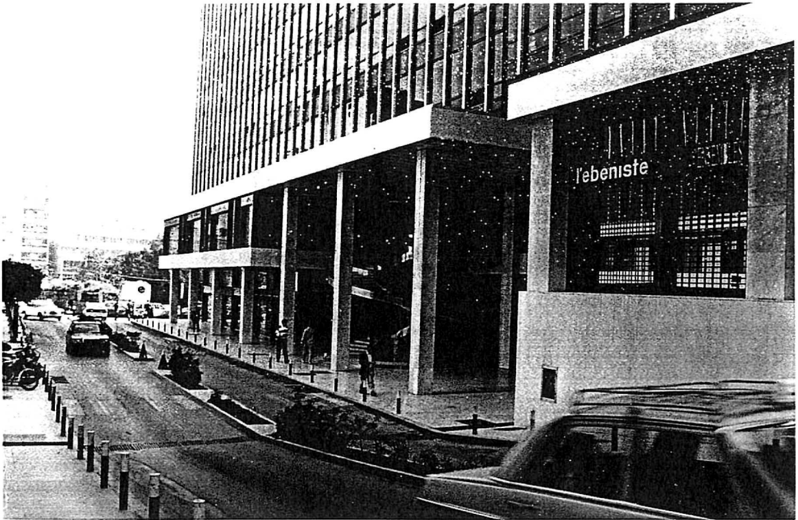
Photographie 26 : Immeuble Gefinor, rue Maamari (Cliché : Boudisseau, 1999)
